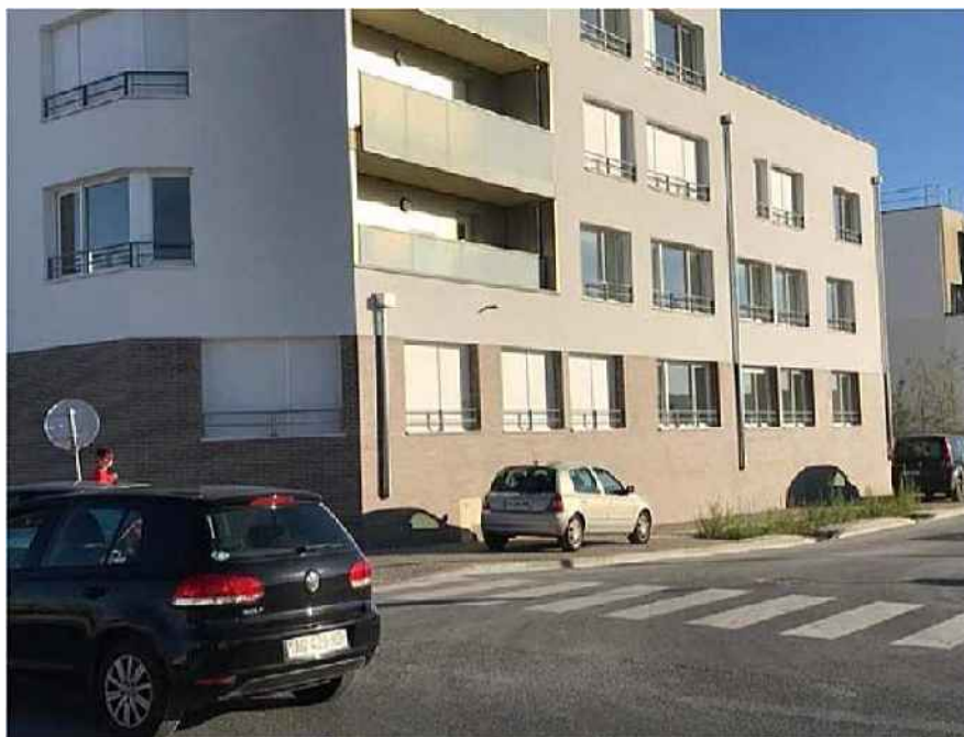
L'immeuble est situé rue Alfred-Kastler. A P.
